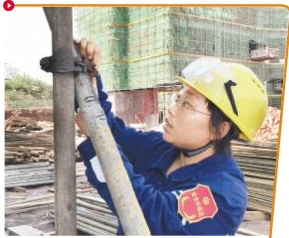
陈玲在项目建设现场进行安全检查
