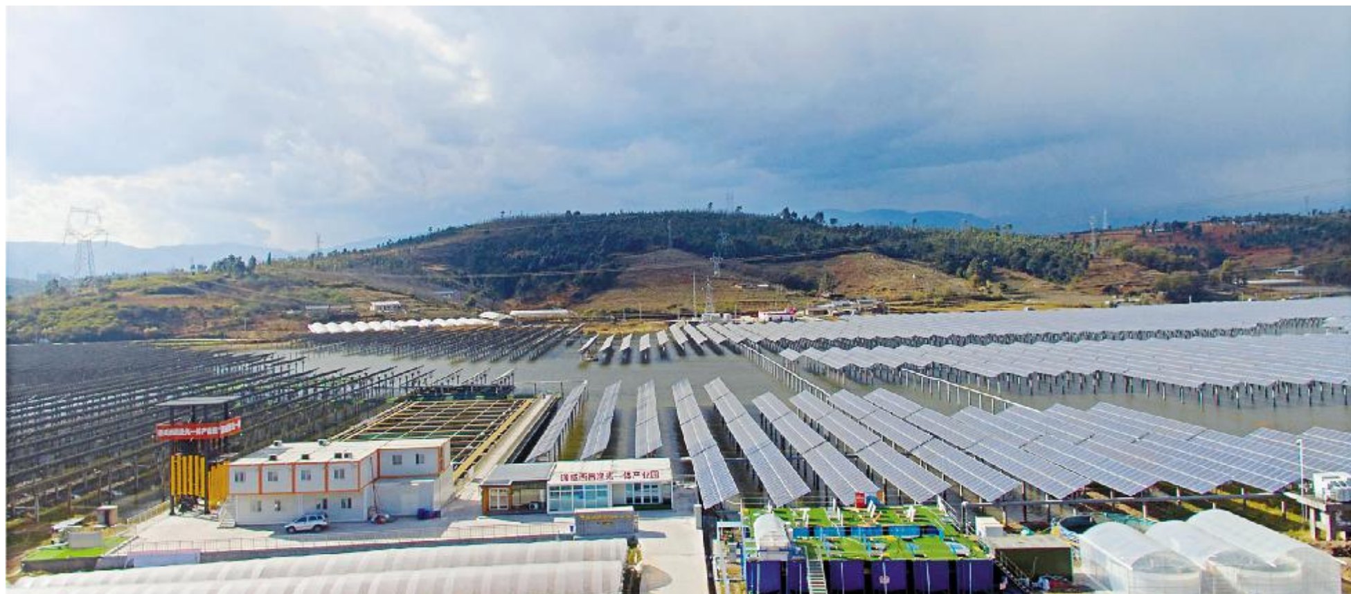
通威西昌“渔光一体”基地
