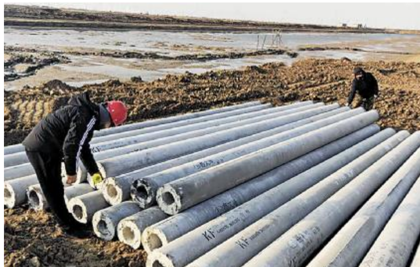
滨州沾化项目清点现场建设物资
