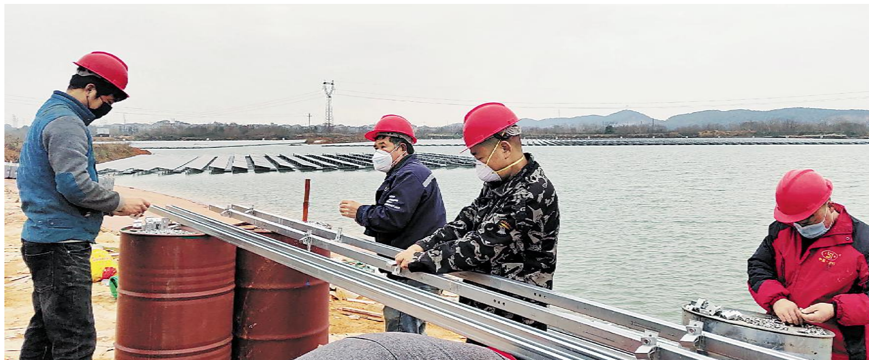
江西高安项目施工现场
