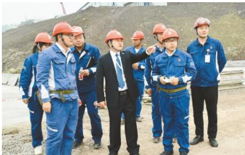
永祥股份董事长兼总经理段雍在永祥新能源二期建设现场指导工作
