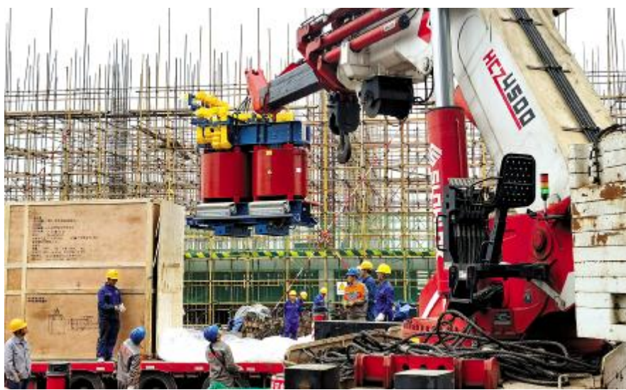
永祥新能源二期还原特种变压器吊装到位
