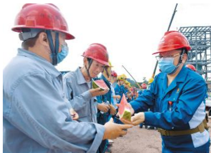
永祥股份董事长兼总经理李斌慰问现场施工人员
