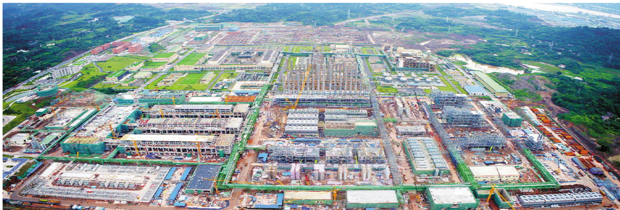
永祥新能源二期项目建设如火如荼
