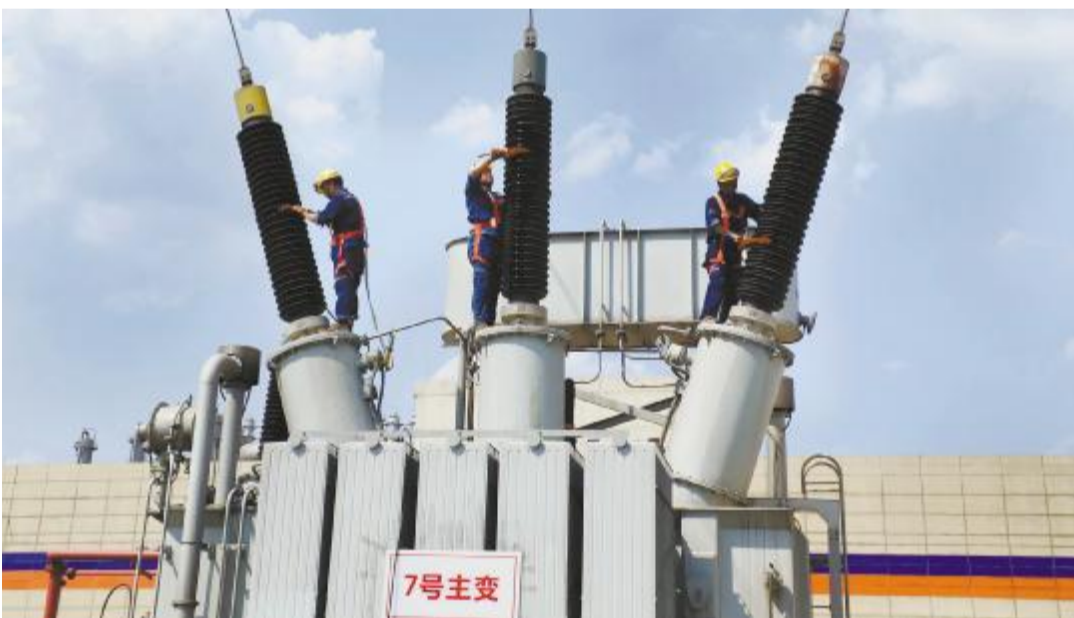
员工冒着高温进行检修作业
