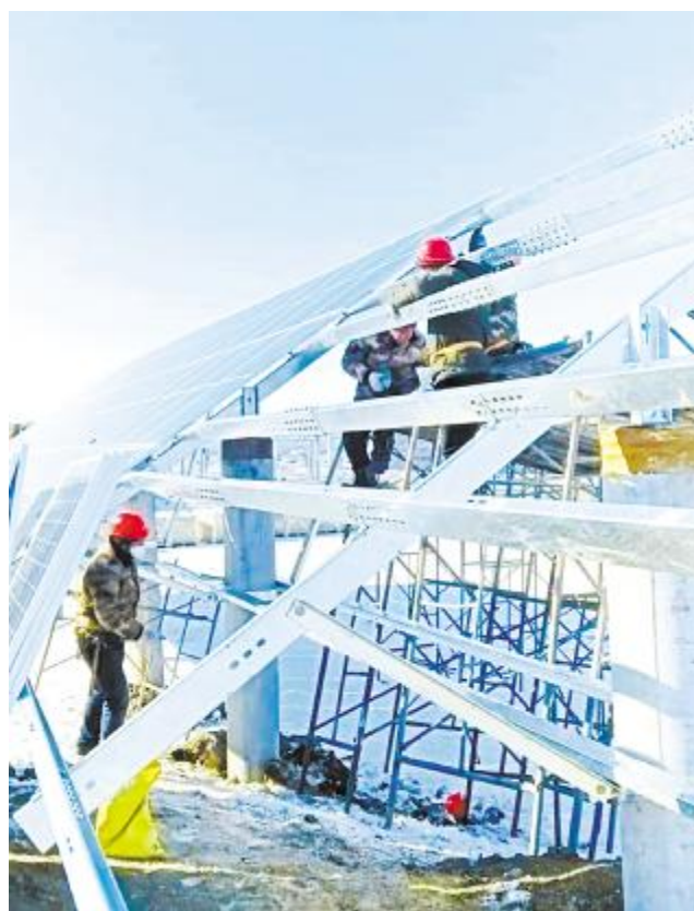
通威“渔光一体”项目建设
