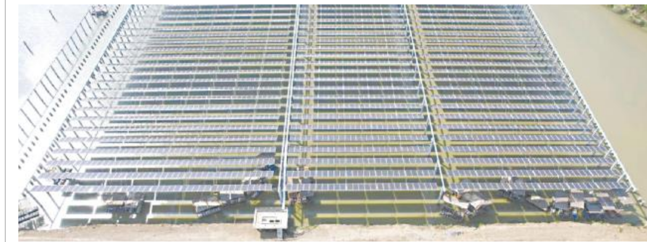
通威天门不等跨索系试验电站建设稳步推进
