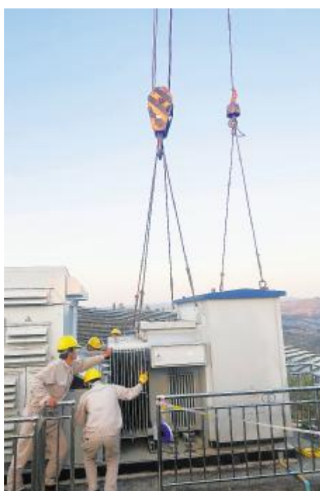
争分夺秒,更换设备
